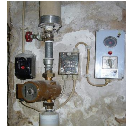
Steuerung Zirkulationspumpe
