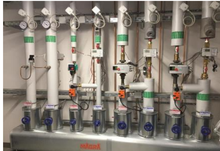
Heizungsverteiler
