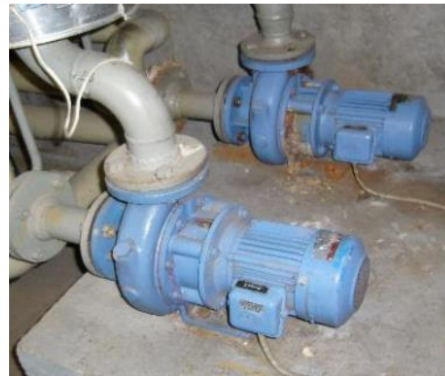
ungeregelte Heizungspumpen
