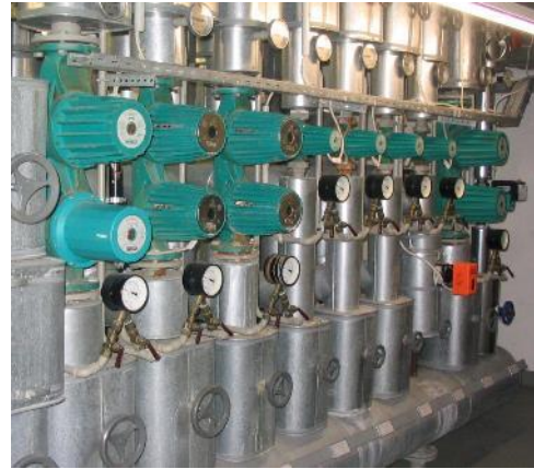
ungeregelte Heizungspumpen
