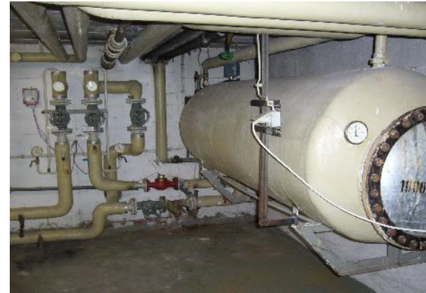
alter Warmwasserspeicher
